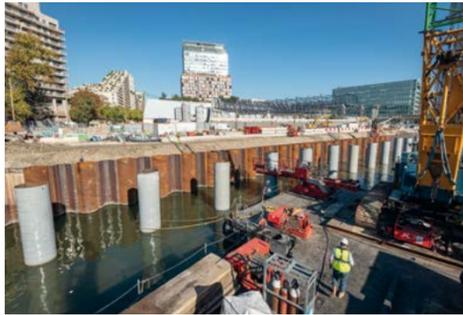
Grâce à cette plateforme qui permettra l'évacuation des déblais par voie fluviale, c'est environ 17 000 camions de 25 tonnes qui seront évités dans le secteur du Pont de Sèvres ! Les plus grands convois fluviaux peuvent en effet remplacer jusqu'à 200 camions par jour.
