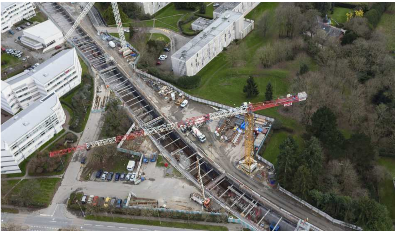
Tranchée couverte métro de Rennes (35)
